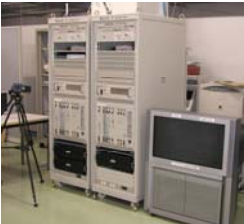
WLAN 伝送システム
